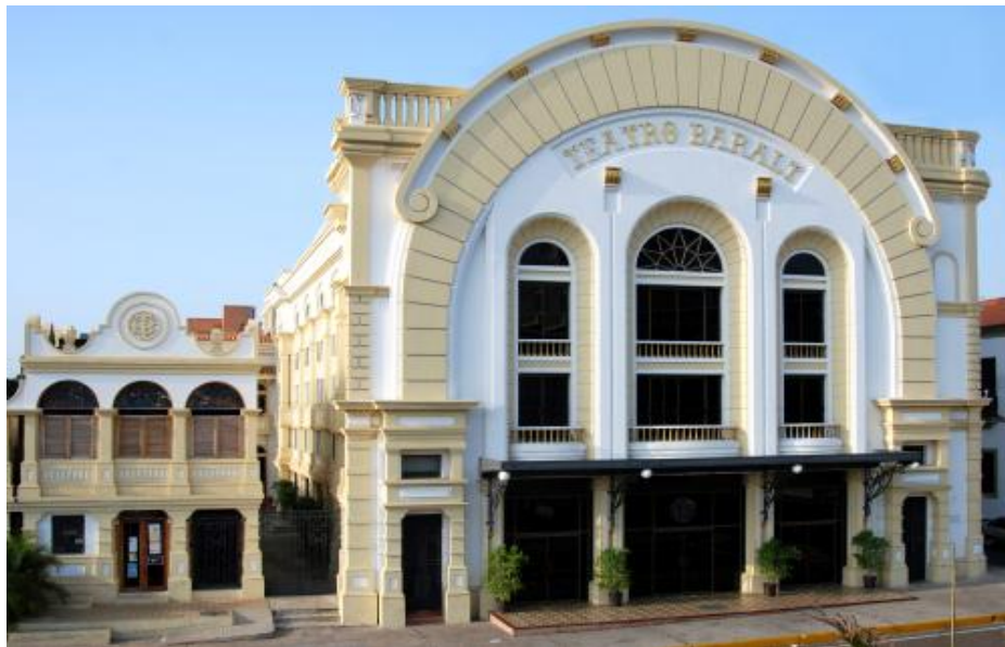
Imagen N°01 – Fachada Principal Teatro Baralt
