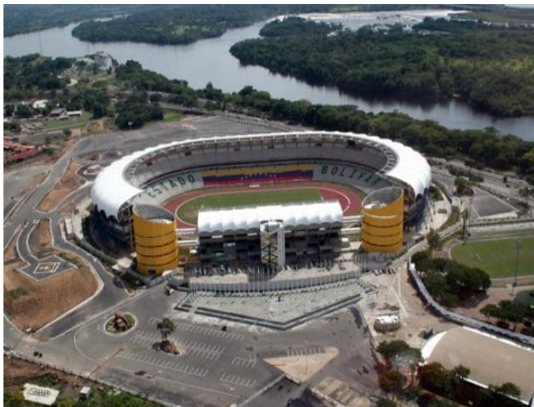
Figura 16: Vista aérea estadio de Cachamay
