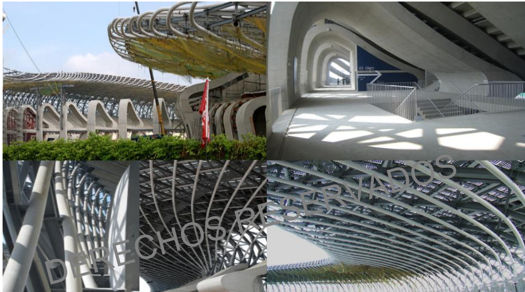
Figura 12: Estructura Estadio Nacional de Kaohsiung Fuente: Google Images (2014)
