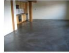
PISO DE CONCRETO PULIDO
